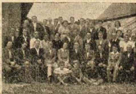
Kolektiv „Remonta“ v Kranju ob priliki svečanega prevzema podjetja. Spredaj sede članj delavskega sveta
