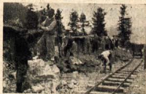
Člani Fronte in množičnih organizacij na Jezerskem so s prostovoljnimi delom pristopili k izgradnji zadržnega doma
