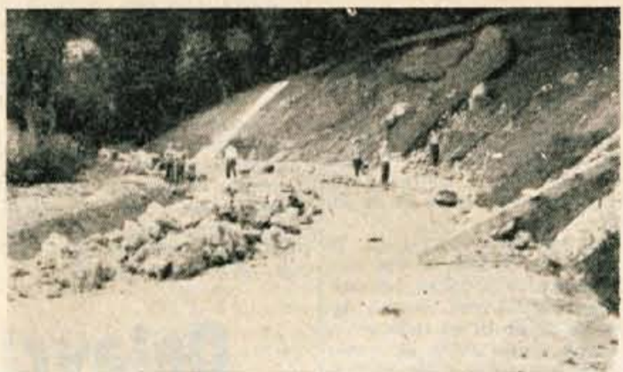
Delavci pri zidanju podpornikov. Dela za odvajanje vode se vršijo višje na pobočju. Povsem na levi je vidna ogrožena hiša
