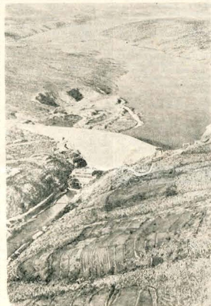
Na sliki vidite 65 metrov visok in 14 km dolg jez jezera Peruče, našega največjega umetnega jezera s kapaciteto 520 milijonov kubičnih metrov vode. Jez je zgrajen ob širokem izlivu reke Cetine
