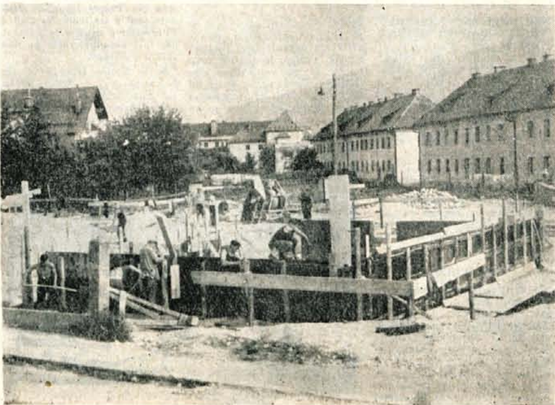
Mrzlica nebotičnikov je zajela tudi Radovljico. Za stavbo ObLO ob Poljski poti so delavci že zgradili temelje za dve manjši stolpnici, kjer bo 33 družin dobilo udobna stanovanja.
