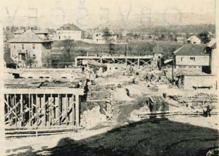
V Radovljici v zadnjem času precej gradijo. Na sliki vidimo gradnjo nove pošte in nekaj stanovanjskih blokov
