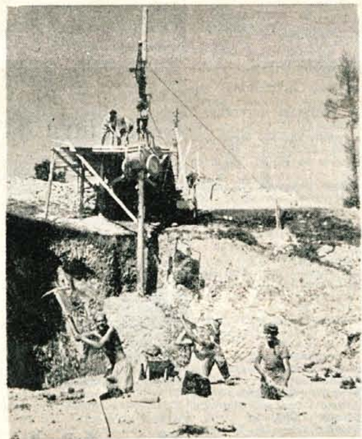
Kopanje glavnega rezervoarja za vodo v Bohinjski Bistrici
