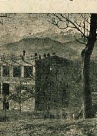
Poslopje nove gimnazije v Žirovnici med gradnjo
