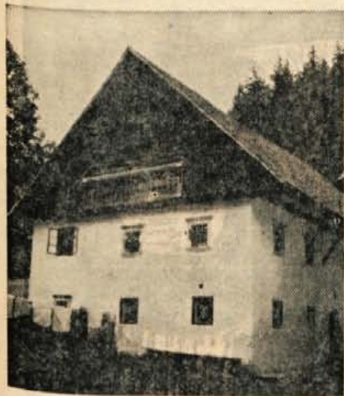
Gruntarska hiša iz Zgornje Radovne z značilnostmi kmečke baročne arhitekture
