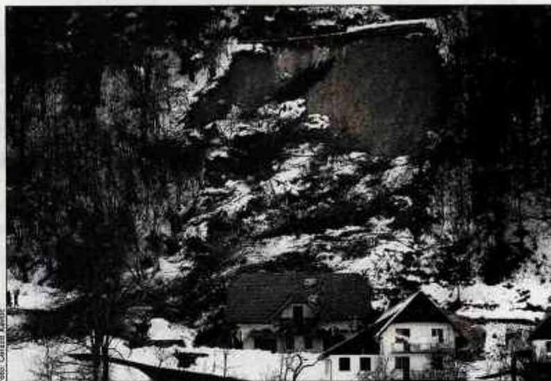
Nad Bremčevim stanovanjem in apartmaji se je v torek popoldne utrgalo celo pobočje.
