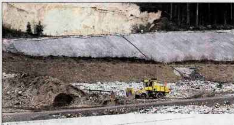
Odlagališče odpadkov na Mali Mežakli
