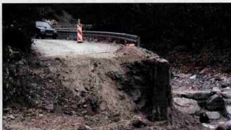
Septembra odprta regionalna cesta v Davčo je od nedelje zaradi porušenega opornega zidu znova zaprta za promet. / Foto: Gorazd Kavčič
