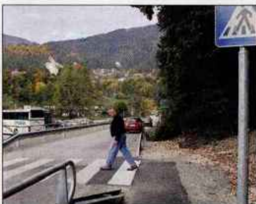
Na Mlaki so zgradili novo pešpot in uredili varen prehod za pešce.
