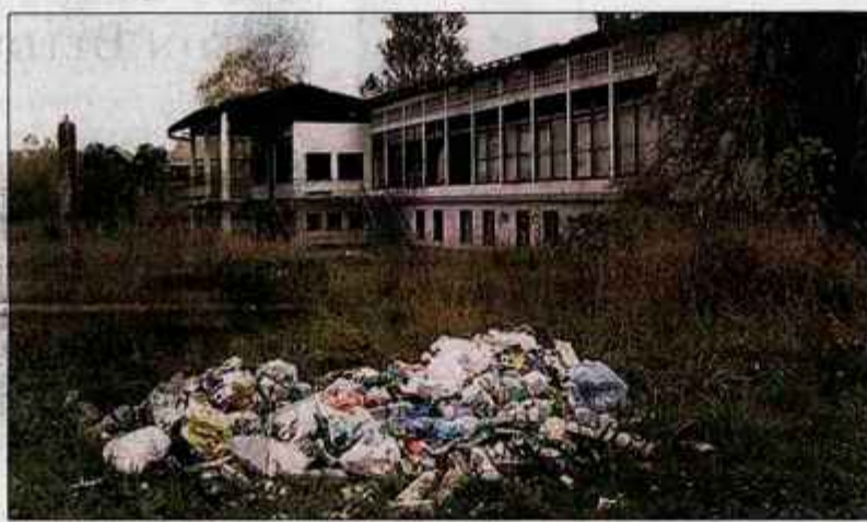
Občinska uprava je v zvezi s propadajočimi objekti ob Sori vložila prijavo inšpekcijam.
