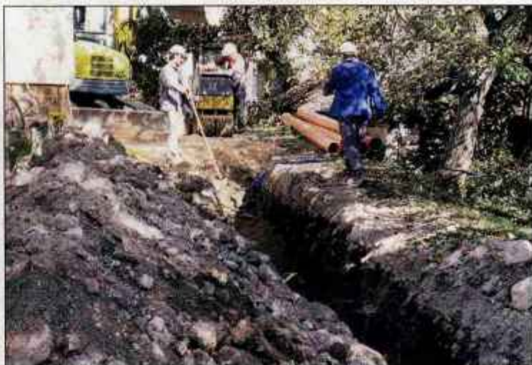
Na Bohinjski Beli s pomočjo evropskih sredstev gradijo vodovod in kanalizacijo.
