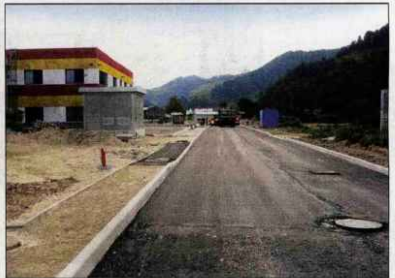
V sredo so cesto, ki pod seboj skriva komunalno infrastrukturo za delovanje Gospodarske cone Žiri, grobo asfaltirali.
