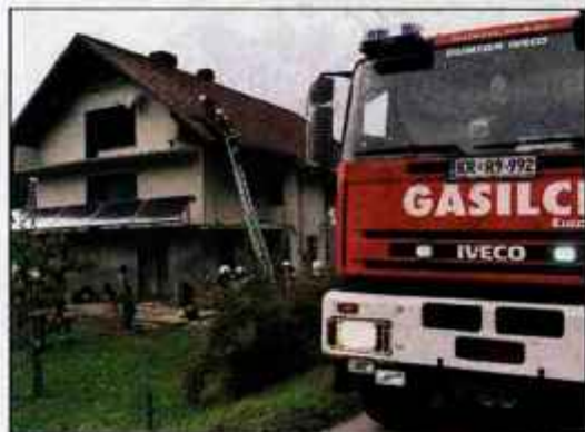
Gasilci so v soboto pomagali pokrivati strehe v Zgornji in Spodnji Lipnici. / Foto: Gorazd Kavčič
