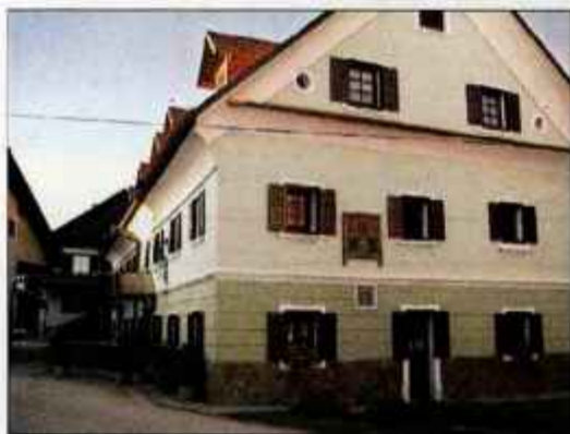
Pri obnovi stare hiše so Sknetovi poskušali čimbolj ohraniti njen nekdanji videz.
