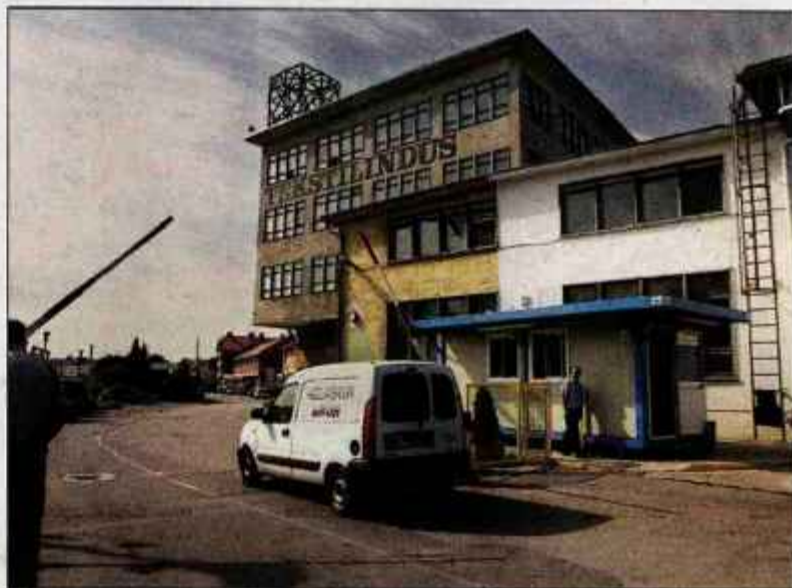
Zapornice ob vhodu v Aquasavo bodo dvigali še do konca oktobra. / Foto: Tina Dolž
