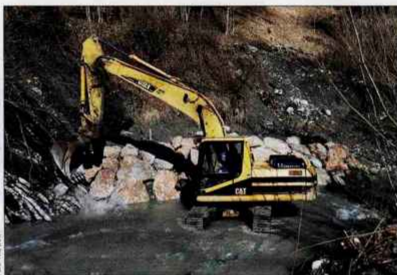
V triletnem sanacijskem programu je za urejanje vodotokov predvidenih 50 milijonov evrov.
