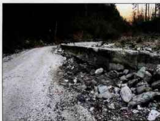
Poškodovana cesta v Davčo / Foto: Tina Deblj
