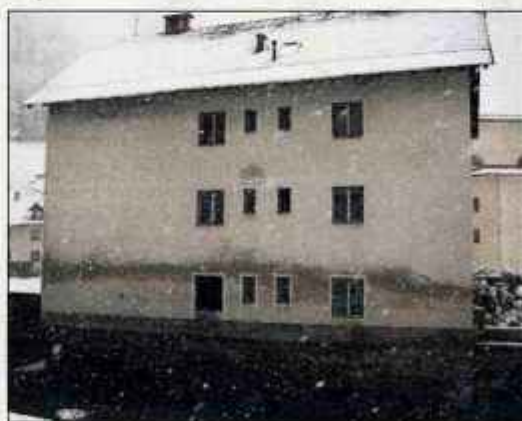
V Železnikih so zaradi poplav že porušili dva stanovanjska objekta na Racovniku, v teh dneh pa rušijo Jegličev dom.
