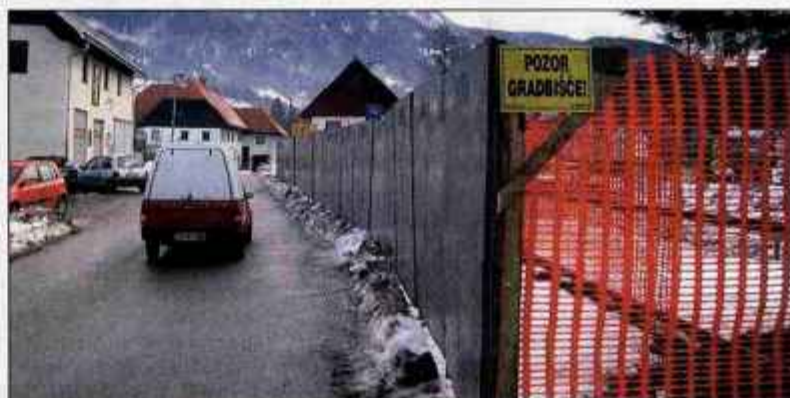
Izvajalec je postavil gradbiščno ograjo na rob pločnika in pešce "izrinil" na prometno cesto.
