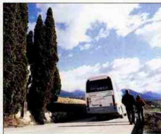
Čeprav je del poti med Spodnjimi in Zgornjimi Gorjami pod Križem za pešce zelo nevaren, pa bo zaradi nesoglasja dveh lastnikov zemljišča ostal tak še naprej. Foto: Anka Bulovec
