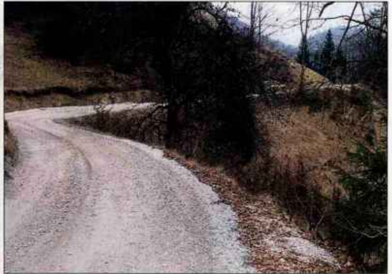
Del makadamske ceste med Čepuljami in Strmico.
