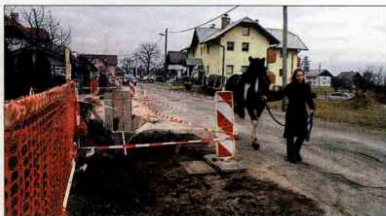
Rekonstrukcija regionalne ceste skozi Žirovnico ter gradnja pločnika ob njej je minuli teden znova stekla. / Foto: Kaja Pogacar
