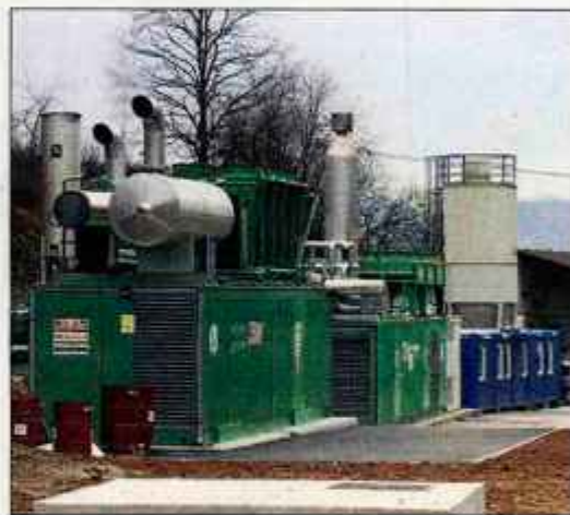
Mala plinska elektrarna. "Smradu zaradi odloženih odpadkov je na odlagališču odpadkov bistveno manj, odkar črpamo deponijski plin; pline, ki nastajajo pri odlaganju odpadkov, uporabljamo kot gorivo v proizvodnji elektrike," pravi Slavko Marš. / Foto: Tina Dežl
