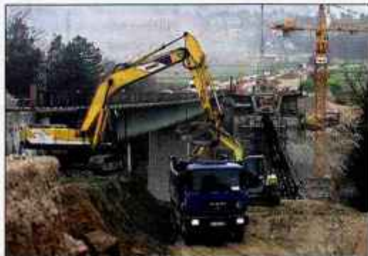
Gradnja viadukta Lešnica. / Foto: Tina Dekl
