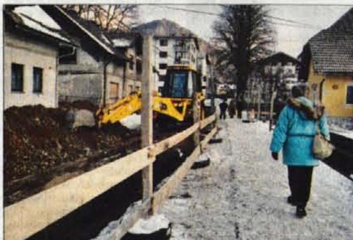
Primarni kolektor vkopujejo po sredi Ceste talcev.
