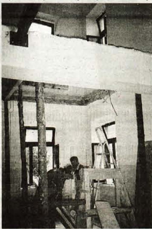
Šola je trenutno brez stropa.
