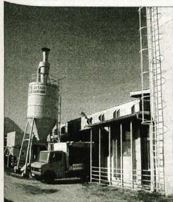
Mizarski obrt v Starem dvoru so zgradili pred trinajstimi leti, del so ga prodali sosednji Komunali. Vsekakor je to Obrtnikovo premoženje, ki je predvsem zaradi lokacije zanimivo za Loko.
