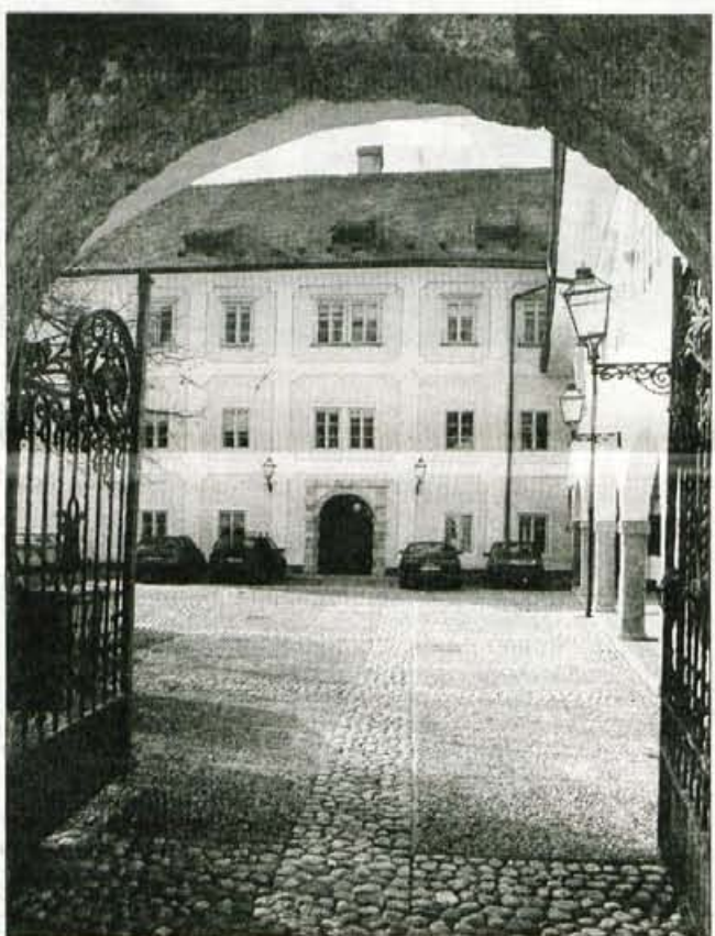
Okoli Gorenjskega muzeja se bo vse leto prašilo: začela so se pripravljati dela za adaptacijo podstrešja in nekatera nujna sanacijska dela na stavbi.
