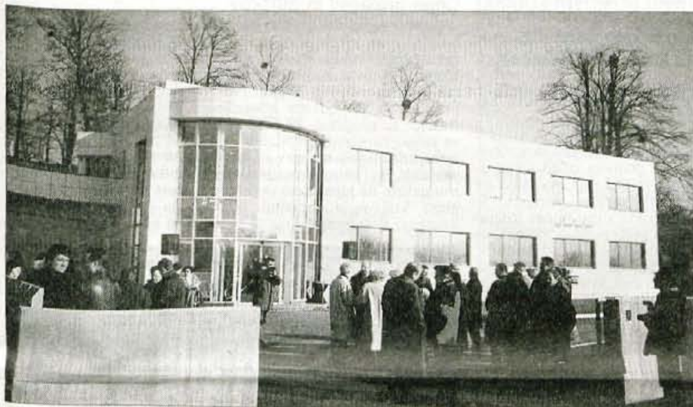
Hrastniška Emma je v leški Rožni dolini odprla poslovno proizvodni objekt, ki je na las podoben posloju sosednjega podjetja Aka in se tako lepo vključuje v okolico.
