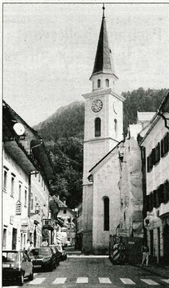
Na Trgu svobode obnavljajo Mehletovo hišo, na Koroški cesti pa bo kmalu na vrsti prenova komunalnih in drugih napeljav.
