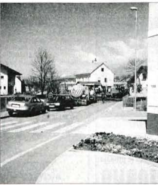
V občini Cerklje neprestano potekajo dela na cestah. Slika je še aprilska, ko so dokončno urejali Barletovo ulico.
