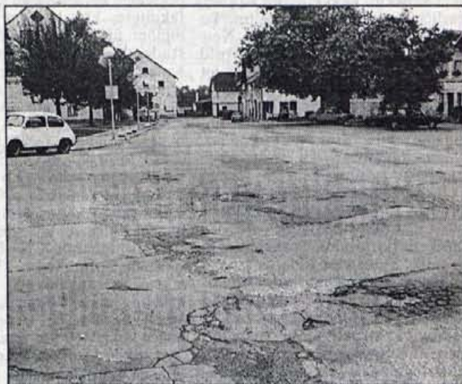
Luknje in zaplate, značilnosti ceste skozi Cerklje.
