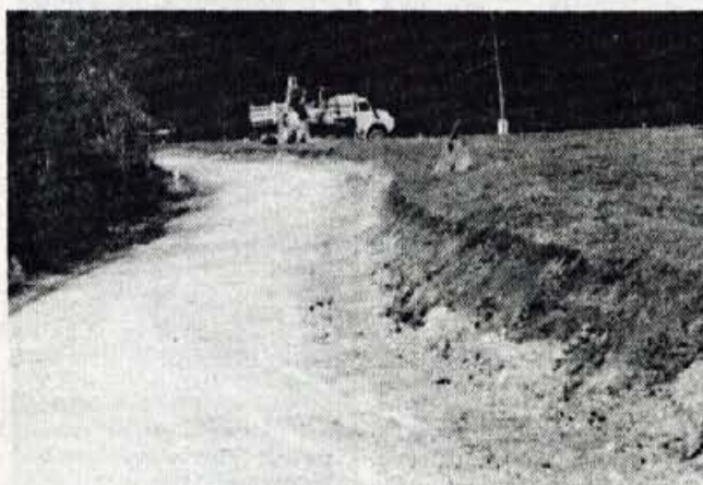
Širjenje ceste v Bašelj - V prejšnjem in tem tednu so začeli obnavljati odsek ceste med Zg. Belo in Bašljem. Dolžina cestnega odseka je približno 300 m, na novo pa so utrdili približno 0,8 m meste na desnem robu. S tem so stekla dela Občine Predvor, v kateri so se odločili najprej obnoviti ceste okoliških vasi. T. K.
