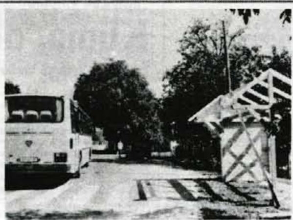
Zvirče, 25. avgusta - Dolgoletna želja prebivalcev naselja Zvirče v trziški občini, da bi na avtobusnih postajališčih na obeh straneh lokalne ceste postavili pokriti čakalnici, se počasi vendarle uresničuje. Denar za material so domačini zbrali že lani, nekaj sredstev pa je prispevala tudi krajevna skupnost Kovor. Čeprav so nekateri že obupavali nad izvajalcem del, je avgusta le začel postavljati oba objekta iz lesa. Kot naročniki upajo, naj bi čakalnici zgotovili še ta mesec. Tege bi bili veseli zlasti šolarji, ki se bodo vozili vsak dan z avtobusom do kovorske oziroma bistriške šole. • S. S.
