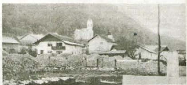
Ker ni bilo denarja, je po izkopu gradbene jame gradnja nove šole lani zastala. Letos, upajo, se bo nadaljevala...
