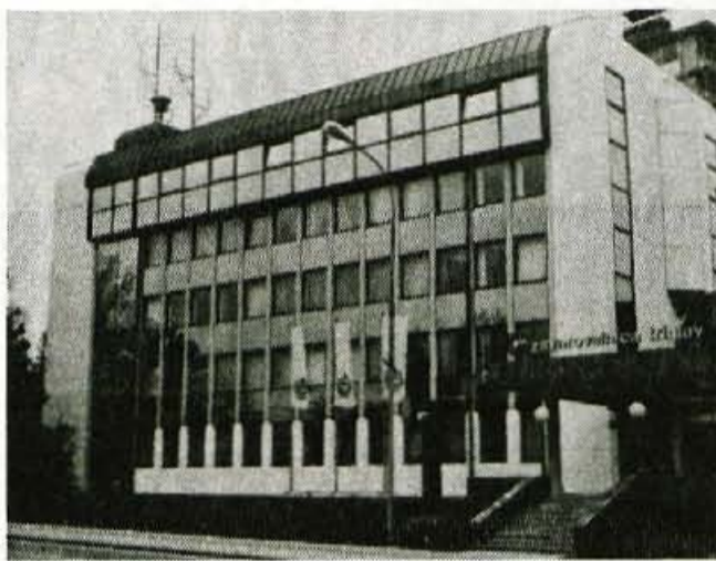
Poslovna stavba Območne enote Kranj Zavarovalnice Triglav
