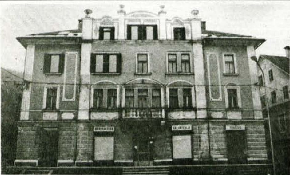
Primožičeva hiša, arhitekturno ena najambicioznejših stavb v Žireh, zgrajena v letih 1912-1924. Zanimivo je, kako se je odtlej spreminjala njena hišna številka: Žiri 83, Žiri 91, Cesta XXXI. divizije 109, Jobstova cesta 29.
