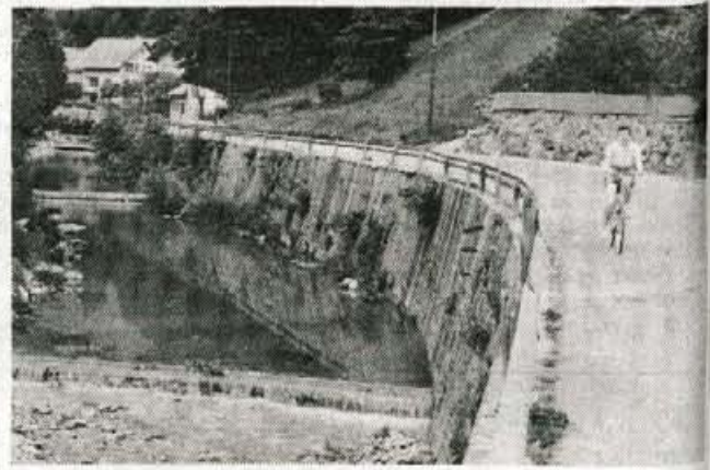
Že nekaj časa v Sori v Železnikih obnavljajo pragove, v kratkem pa se bodo začela popravila opornih zidov. V krajevni skupnosti, kjer so bili že zaskrbljeni, da ne bi morebitna še ena večja voda povzročila pravega razdejjanja, so si zdaj oddahnil.
