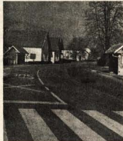
Predvsem s prostovoljnimi deli oziroma akcijami ob sobotah in nedeljah so pred časom zgradili tri avtobusna postajališča...
