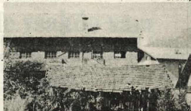
Baraka na Koroški Beli se bo zdaj zdaj podrla, do prve etaže pa bi morali podreti tudi bližnje visoko stavbo... Foto: D. Sedej
