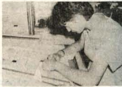
Tudi montaža strani je zahtevno in natančno delo.
