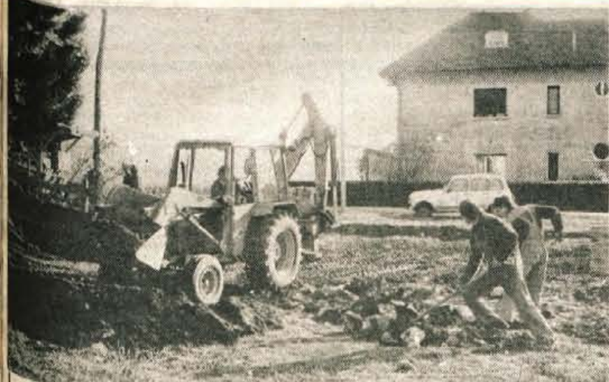
Začela se je gradnja telefonske centrale v Križah — Trzičanom in vsem tržiškim krajevnim skupnostim se je te dni oddahnilo: v Križah so po dolgih pripravah le zasadili prve lopate za gradnjo temeljev nove telefonske centrale, ki bo imela zmogljivost okrog 1000 priključkov. Gradnjo je prevzel Gradbincec iz Trziča, dokončana pa naj bi bila do konca junija 1987. Sama centrala je že plačana in bo dobavljena že do konca letošnjega leta. — Foto: D. D.
