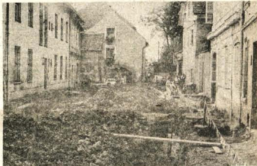
1. septembra je Komunalno obrtno gradbeno podjetje Kranj začelo urejati Gasilski trg v Kranju. Investitor tega dokaj zahtevnega projekta, ki naj bi bil izveden skladno s programom revitalizacije starega mesta Kranja, je samoupravna komunalna interesna skupnost Kranj. Dela v dolžini 65 in širini 10 do 16 metrov naj bi bila končana do konca oktobra letos.
