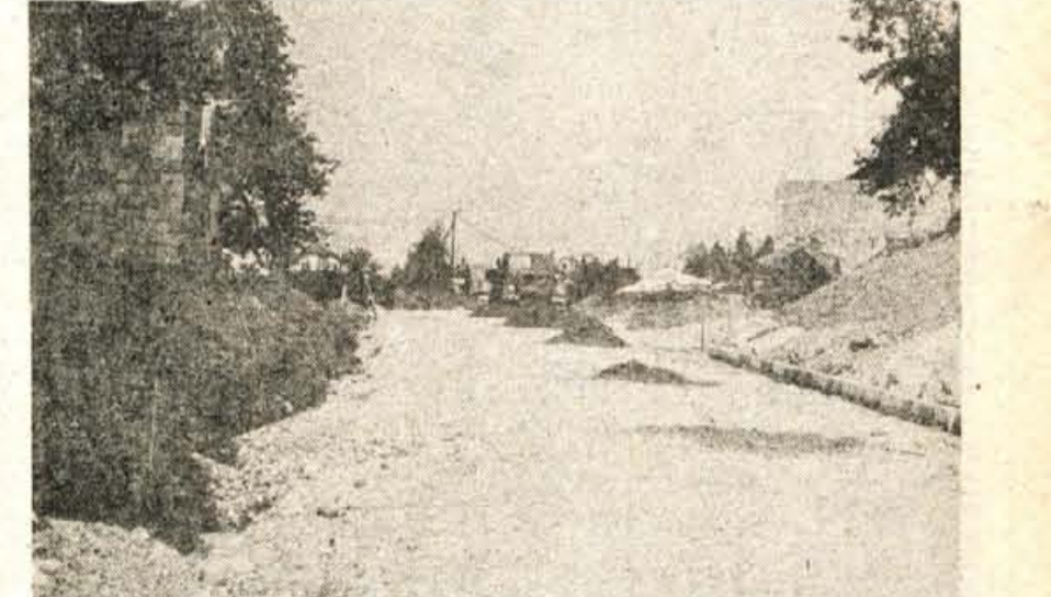
V zgornjem delu je cestišče za letos skoraj gotovo in bo počakalo do spomladaj, ko bodo položili še asfalt. Glede pomembnosti in zahtevnosti del po nekaj podatkih: izkopati bo treba 14.900 kubičnih metrov materiala, za ureditev nasipov bo potrebno 2.400 kubičnih metrov in še dodatnih 1000 kubičnih metrov humusa za ureditev 9.100 kvadratnih metrov brežin.
