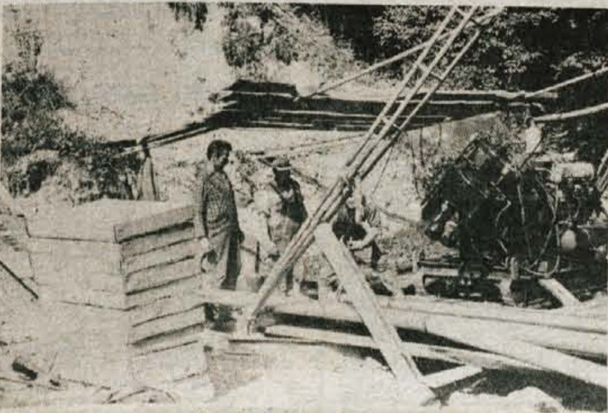
Augusta meseca so delavci Geološkega zavoda iz Ljubljane pričeli z vrtanjem v gramoznici nad Poveljami (Trstenik), da bi našli nove izvire pitne vode. Pričrtali so že v globino 80 m toda še vedno niso našli na spravo žilov. Računajo, da se jim bo delo izplačalo pri 120 m, torej čez kakih 14 dni. — I. S.
