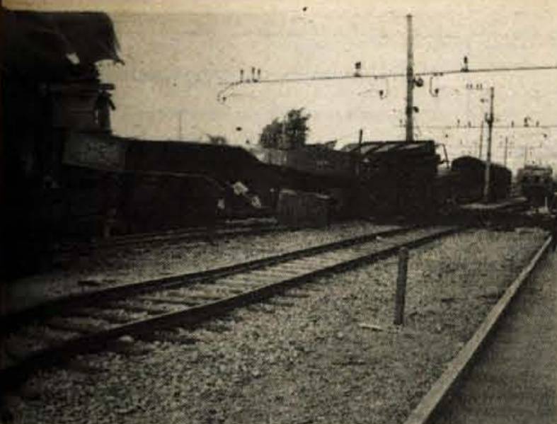
— V petek, 8. maja popoldne, je na železniškem vozlišču v Kranju iztirilo 13 tovornih vagonov. En vagon je iztiril že v dvojnem tiru pred Globokim, okoli 8 kilometrov pred leško železniško postajo. Vagon, ki je iztiril, je drsel z eno osjo po progi vse do južne proge št. 2, kjer so iztirili še ostali. Pri tem se je devet vagonov prevrnilo, tovor pa razsul po progi. Zaradi iztirjenja je bila proga več ur čisto nevarna, prav tako tudi drog električne napeljave in desni tir. Progo so popravili, tako da je promet spet stekel v soboto, 9. maja, zjutraj. Vzrok nezgode še ni pojasnjen, domnevajo pa, da bi lahko prišlo do okvare na enem od vagonov, ali pa se je na enem od vagonov premaknil težak tovor. Škodo cenijo na okoli 5 milijonov din.
