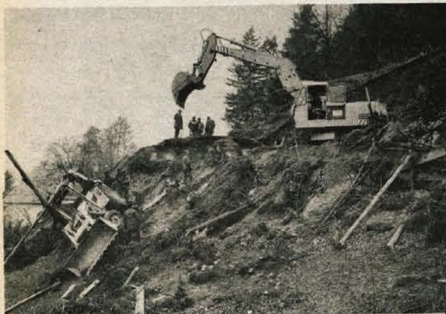
Zemeljski plaz na Selu – Zgodaj jutraj, v nedeljo, 23. novembra, je pri vasi Selo začel drseti zemeljski plaz po dolžini sto metrov. Porušil je električni drog, zato so izklopili bližnji električni transformator ter priklučili prenosnega. Posledice plazu odstranjujejo delavci gradbenega podjetja Grad Bled. – Foto: F. Perdan
