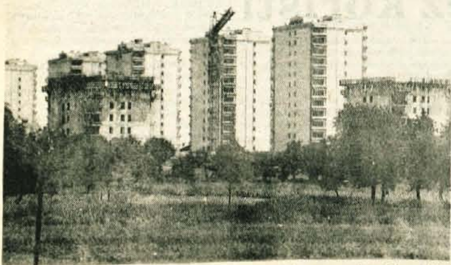
V Podlubniku, kjer se gradnja počasi približuje koncu, gradijo delavci SGP Tehnika dve trinajstnadstropni stolpnici, v katerih bodo dobili stanovanja delavci škofjeloških delovnih organizacij. — Foto: F. Perdan
