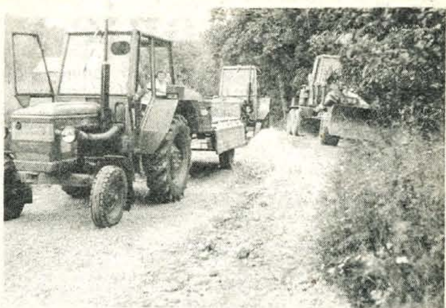
»Udarniška« na cesti v Babni vrt - Večina krajanov Babnega vrta v krajevni skupnosti Trstenik se je v soboto udeležila udarniškega dela na cesti v Babni vrt. V akciji so sodelovali tudi traktorji in bagri. Krajanje so uredili 1400 metrov dolgo cesto do take mere, da bodo, ta teden nanjo lahko že ugradili asfalt. Do vasi bo širok 3,5 metra, po vasi pa meter manj. Za asfaltiranje in urejevanje ceste so krajanje zbirali denar s samoprispevkom in opravili prostovoljno delo vredno 75 starih milijonov dinarjev. 60 starih milijonov pa je dala krajska skupščina. Asfaltna cesta bo za Babni vrt velika pridobitev. V trsteniški krajevni skupnosti se resno lotujejo tudi odstranjevanja posledic potresa. Največja ovira je pomanjkanje gradbene dokumentacije. (jk) - Foto: J. Zaplotnik
