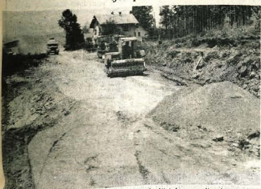
Cesta od leškega Žita do klavnice v Radovljici bo zaradi rekonstrukcije zaprta od 5. julija do 25. avgusta. — Foto: J. Zaplotnik
