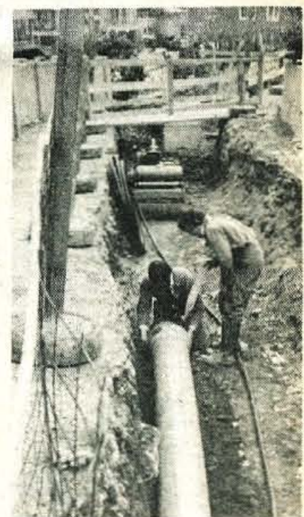
Koroška Bela — Zaradi pomanjkanja vode so pred nekaj leti do Jesenic napeljali pitno vodo iz zajeta na Peričniku v Vratih. Da bi zadostili potrebam po vodi na vsem širšem področju Jesenic, zdaj speljujejo to vodo od rezervoarja do rezervoarja. Lani so jo tako speljali do Pejc in Mesarjevega travnika, letos pa polagajo cev nad hišami Tomšičeve ceste. Cevi polagajo delavci jeseniškega Vodovoda. Foto B. B.
