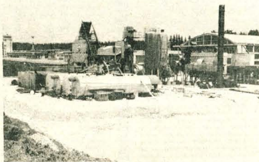
Asfaltna in betonska baza ob letališču in se dve stovarni asfaltni v Črnučah in v Mengšu bodo med rekonstrukcijo brniškega letališča sposobne pripraviti na uro 600 ton asfaltni. Sicer pa bodo delavci Slovenija ceste ugradili v dveh mesecih na vzletnopristajalno stezo brniškega letališča 230.000 kvadratnih metrov najmanj 21 centimetrov debelega asfaltni. — Foto: F. Perdan
