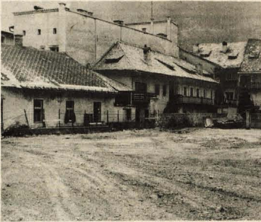
Pomanjkanje parkirnih prostorov že leta gnjavi Tržičane. Parkirna kriza bo z ureditvijo parkirnega prostora za hotelom Pošta, kjer so porušili razpadajočo sindikalno dvorano, milejša. - Foto: F. Perdan
