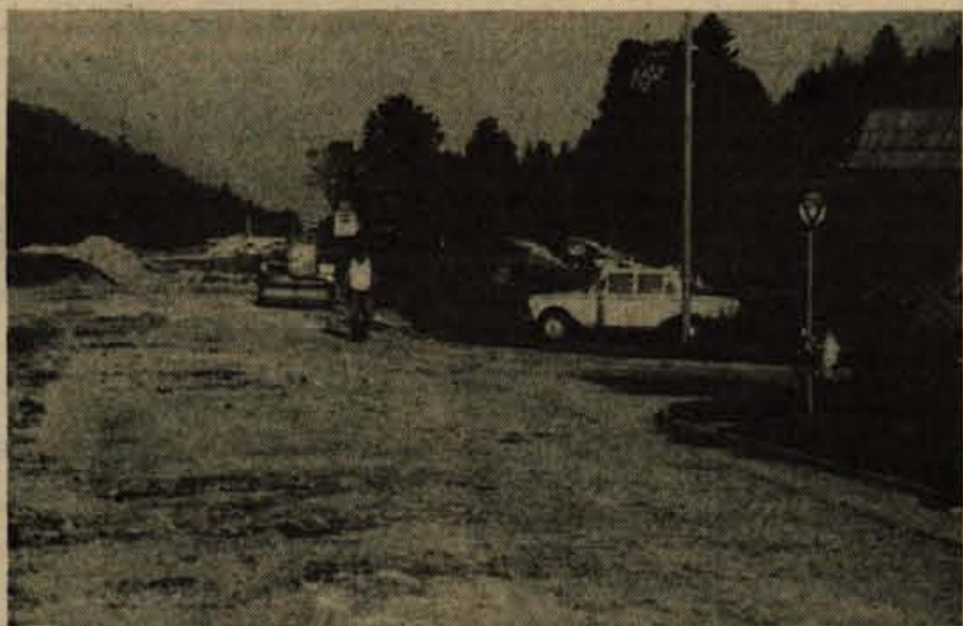
Kranjska gora — Rekonstrukcija ceste — V začetku avgusta so začeli delavci Cestnega podjetja Kranj širiti in obnavljati cesto od Kranjske gore do Podkorena. Promet zdaj poteka po lepo speljani in asfaltirani cesti na trasi nekdanje železniške proge. Nov del ceste bo nared do zime, dela pa bodo veljala nekaj več kot 7 milijonov dinarjev. Obvoznice, ki so jo ob tem zgradili, ne bodo podrli, ker je bodo uporabljali za smučarske teke ter vožnjo z upreznimi sanmi. — Foto: B. B.
