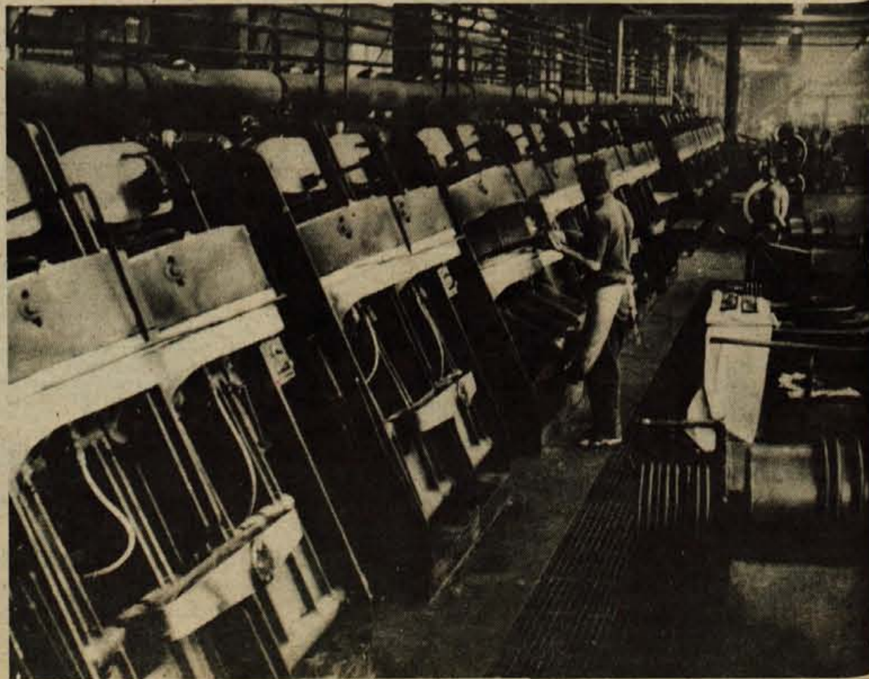
»Sava« - oddelek za vulkanizacijo veloplastev (plaščev za bicikle)
